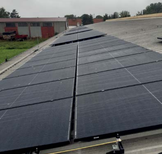
Budování fotovoltaiky na ŠZP
